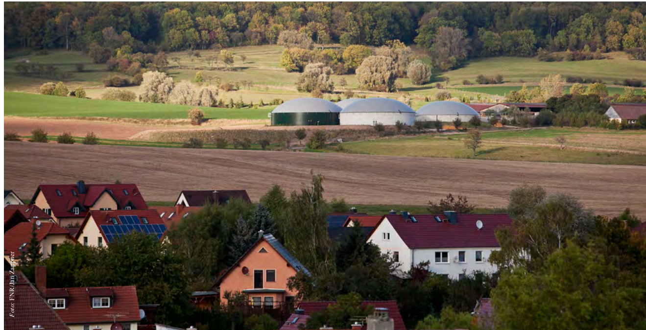
Selbstversorger: Das Bioenergiedorf Schlöben versorgt sich mit Strom aus einer Biogas-Anlage.
